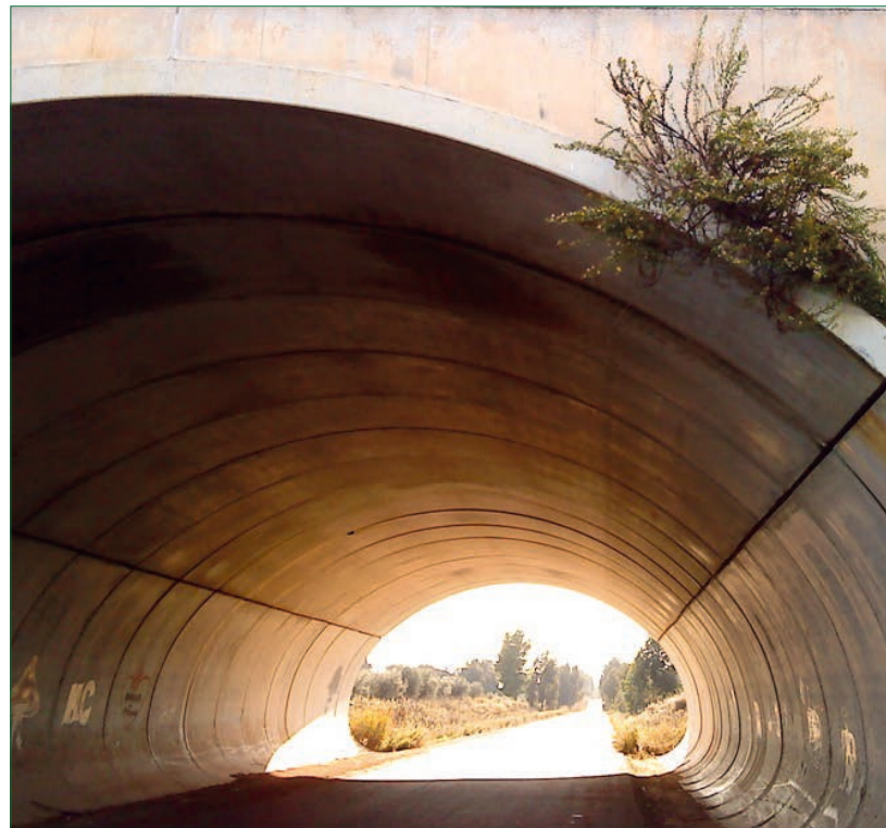
FOTOGRAFÍA: "Viaducto de Betão" João Portugal
